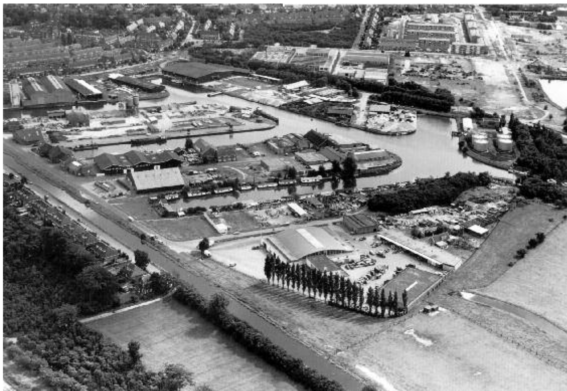
Luchtfoto van het Nieuwe Havengebied uit 1961 met op de voorgrond de veilinghal. (coll. SAGV)
