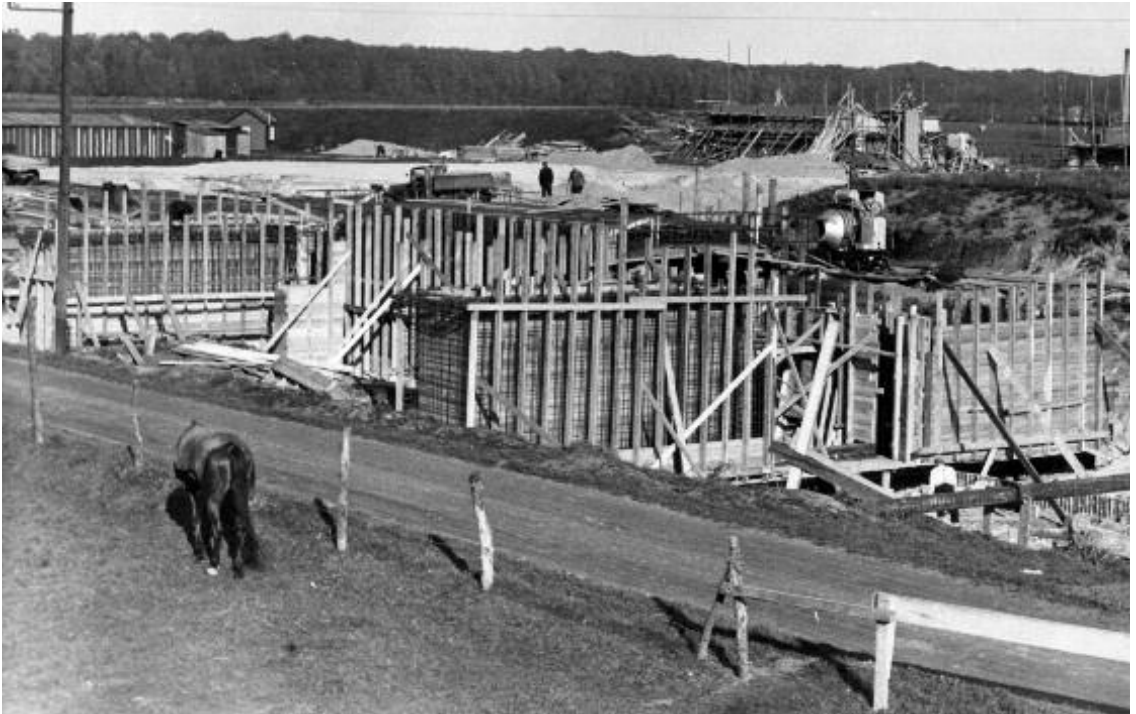
Aanleg van de duiker met sluis onder de aan te leggen Vreelandseweg. De sluis was gericht op recreatief vaarverkeer en verbond het nieuwe kanaal via het vervolg van de 's-Gravelandse Vaart met het plassegebied van Loosdrecht. Rechts boven de aanleg van de nieuwe brug naar 's-Graveland. Het Hilversums Kanaal lijkt op deze foto nog niet gegraven. Situatie 1932. (foto coll. SAGV)
