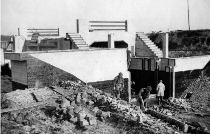
De vrijwel voltooide duiker met sluis onder de Vreelandseweg bij 's-Graveland, die het tracé van het Hilversums Kanaal verbindt met de Loosdrechtse Plassen. Situatie oktober 1934. De sluis werd een aantal jaren geleden vervangen door een dichtbij gelegen 'groene' sluis aan de Kromme Rade, die door de recreanten zelf bediend kan worden. Hoogteverschil 10 centimeter. (foto coll. SAGV)
