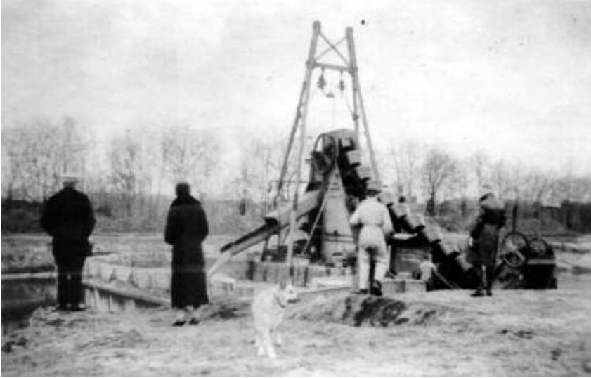
Een baggermolen verricht graafwerk aan het kanaal. Een ander deel werd met de hand gegraven als werkverschaffingsproject in crisistijd. (coll. mevr. Oostendorp, Hilversum)
