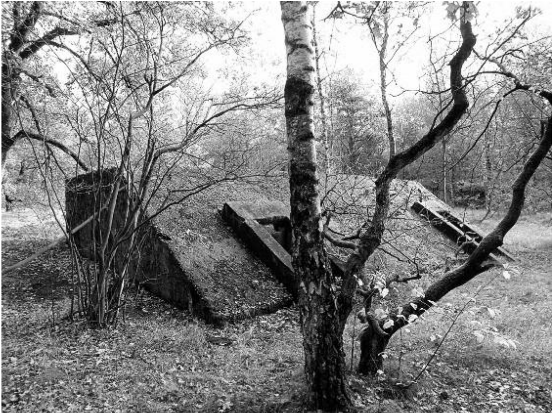
Afb. 7. Een van de grote groepsschuilplaatsen op de Franche Kamp.
