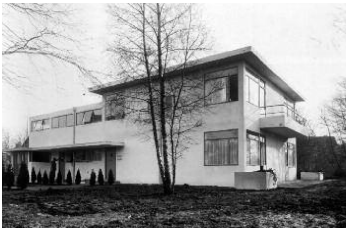
Woonhuis Doyer, Joelaan, 1929. Het huis heeft een voor die tijd vernieuwende, geheel betonnen constructie.
