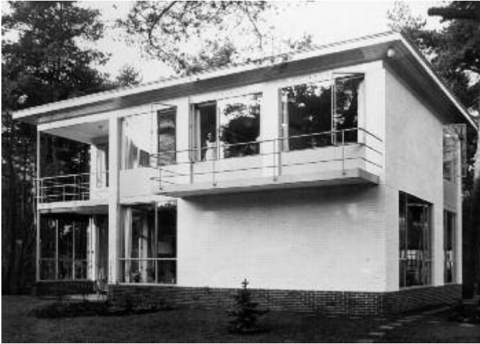
Woonhuis Liebert, Rossinilaan, 1935-1936.
