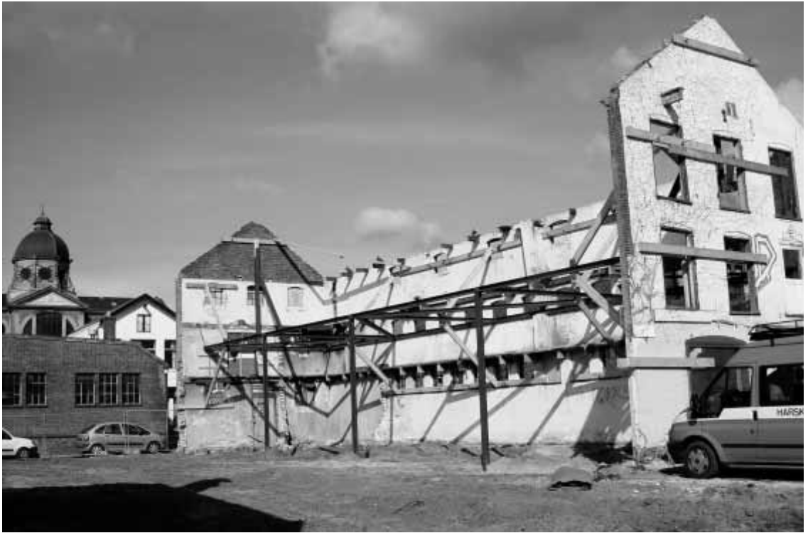
Bij het nieuwbouwproject van Philadelphia bleef er van de oude logerij aan de Naarderstraat niet veel meer dan enkele buitenmuren staan. Volgens de gemeente komt het allemaal goed. (foto EJP, april 2008).
