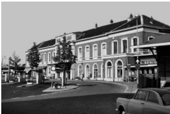
Station Hilversum, 1969. Het oude HIJSM-station uit 1874. De uitbouw rechts aan de voorkant is van later datum; dat was lange tijd de wachtkamer voor buspassagiers. Geheel rechts is nog net een stukje van de overkapping van de loods van Van Gend en Loos te zien. (foto: Nico Spilt, Bunnik)
