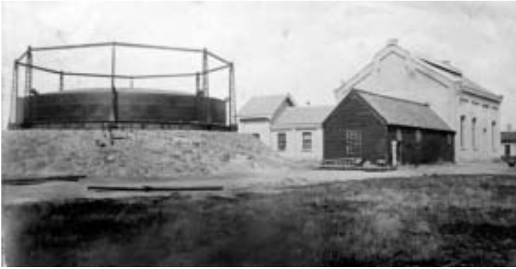
De Bussumse gasfabriek van Hafkenscheid, ca 1886. Deze gasfabriek zal voor een belangrijk deel opgebouwd zijn met apparaten en onderdelen van de Hilversumse fabriek, zodat we mogen verwachten dat deze foto een beeld geeft van hoe de laatstgenoemde fabriek er ongeveer uitzag. (coll. SAN)
