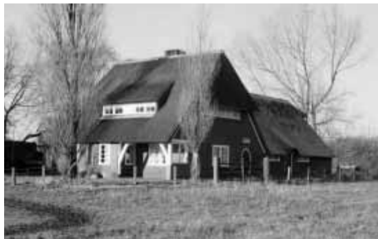
Bij de Berg van Houtman stonden twee boerderijen, waar dit er één van is. De fraaie panden moesten, evenals de berg zelf, in 1990 plaats maken voor de bouw van de Theresiahof. (foto: Wim Frisart)
