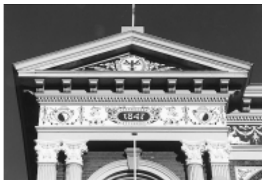
De gevel van Studentensociëteit Phoenix in Delft. Onder de gootlijst en in de tympanen komt sgraffitowerk voor. Enkele jaren geleden is de gevel gerestaureerd. Het lijkt erop, dat de afbeeldingen toen geschilderd zijn. (coll. mon.zorg. Hilversum)
