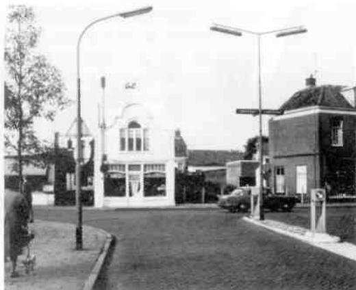
In september 1968 viel het eerste gat. Het huis met nummer 58 werd afgebroken. Er ontstond zicht op het dak van de Jonge Graaf van Buuren (foto: Goois Museum).
