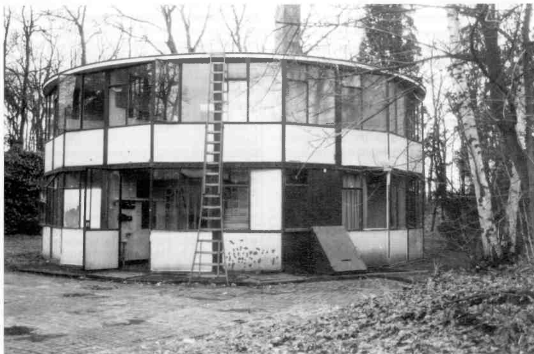
Het dienstbodenhuis "De Koepel" op Zonnestraal is nog in originele en redelijk gave staat. Studenten Bouwkunde aan de TU Delft maken momenteel plannen voor een totale renovatie (foto STYLOD, Delft).
