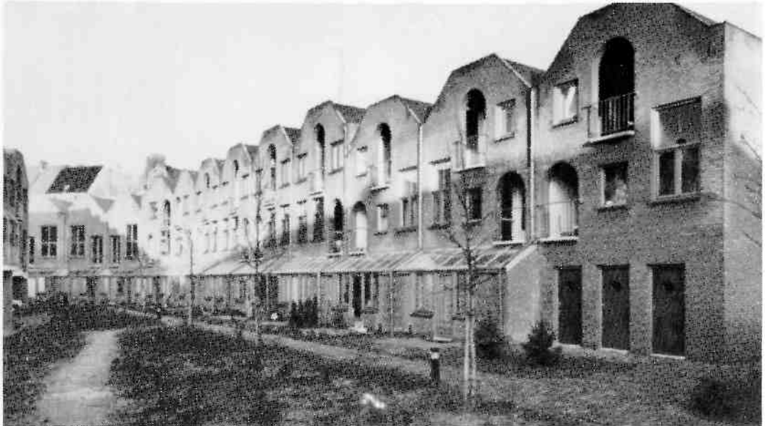
Zwolle. Woningbouwproject van Aldo van Eyck en Theo Bosch 1977. Gaten in de stad werden na de sloopwoede van de jaren '60 opgevuld. Een vroeg voorbeeld van vormtaal die in heel Nederland navolging vond.
