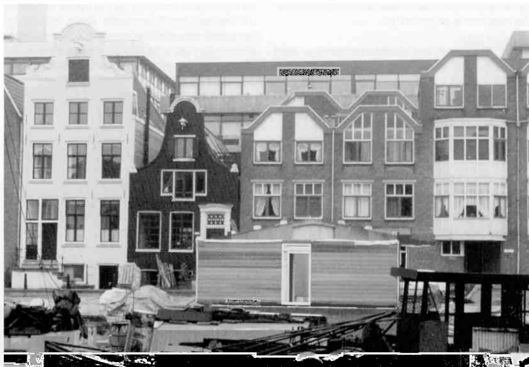
Stadsvernieuwingsproject Bickerseiland Amsterdam van Paul de Ley en Jouke van den Bout. Menging van bedrijven en woningen, van oude bebouwing en aangepaste nieuwbouw (foto: JEL)
