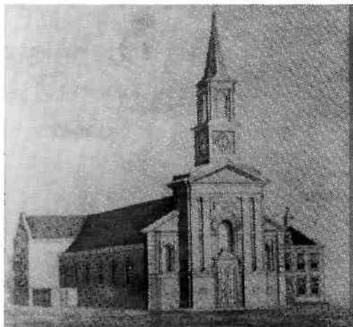
De nieuwe 'Griekse' voorgevel na de verbouwing van 1853.
