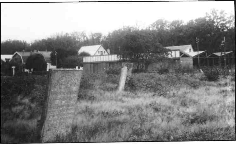
Het gebouw van de 'Coöperatieve Veilingvereniging Hilversum en Omstreken' gezien vanaf het voormalige Israëlitische Kerkhof aan de overkant van de Vaart, waar nu de Nieuwe Havenweg loopt. De foto werd ca. 1930 genomen. (coll. Goois Museum)
