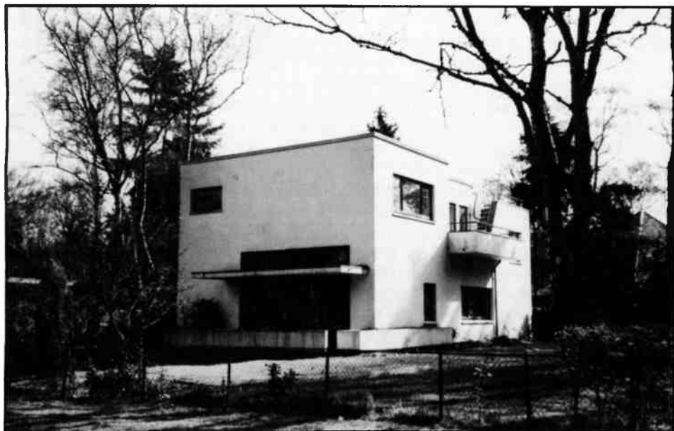
Hertog Hendriklaan 1, 1929. De gevels van deze villa zijn nog niet zo open. In de villa is de invloed van R. van 't Hoff aan te wijzen, een architect die Elling in die tijd zeer bewonderde. De invloed is met name te herkennen in de horizontale accenten van de luifels en de bloembakken. Dit is de enige villa met een dakterras, een gewild element bij de architecten van het Nieuwe Bouwen, om in contact te kunnen komen met de omringende natuur.
